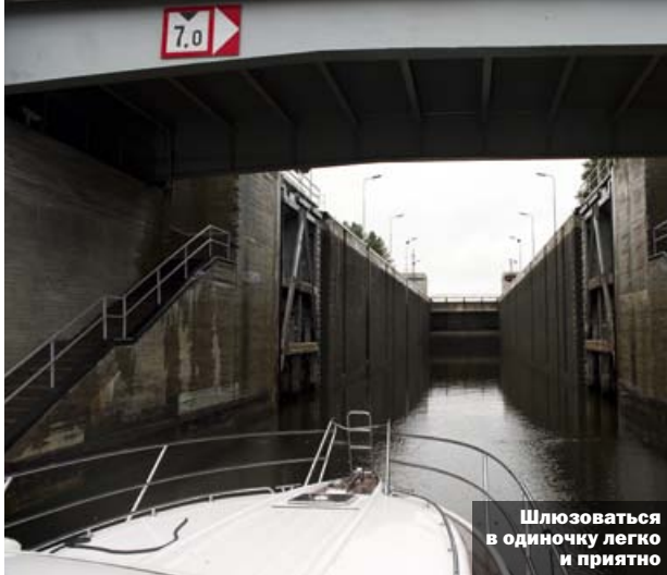
Плавающие рымы есть только на одной стенке шлюза
