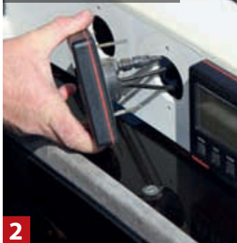
Подключите кабели к распределительной коробке
