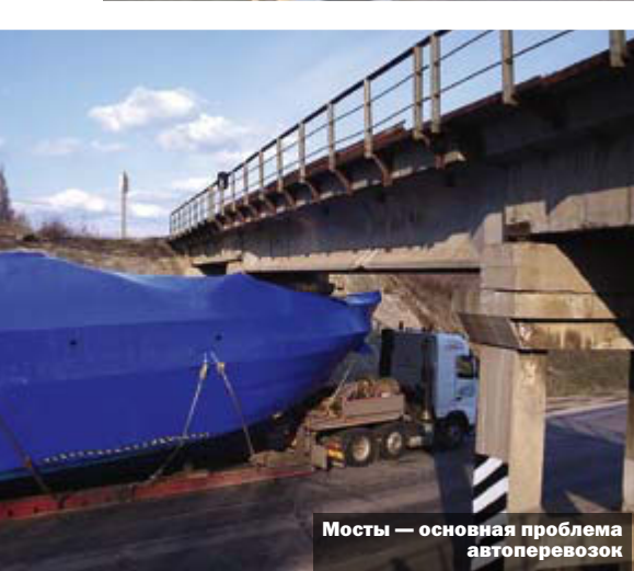
В некоторых случаях автоприцеп приходится практически опускать на дорожное полотно
