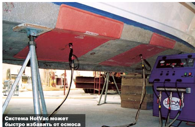
Температура и вакуум могут повредить корпус, поэтому работу должны выполнять профессионалы
